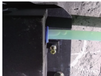
图19 液管中产生气泡
