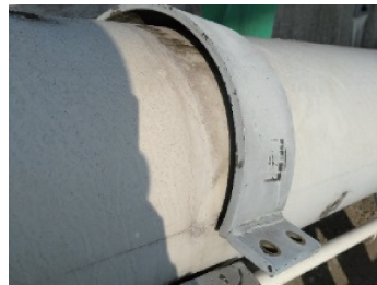
图2 阻尼器螺栓缺失
