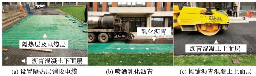
图3 试验路段施工工序
