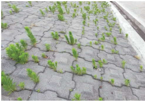
图 8 水库下游坝坡预制块(107 m 高程以上)
