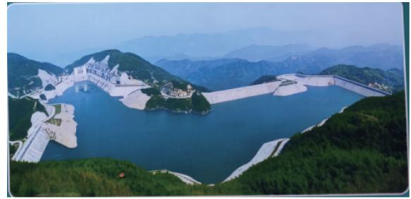
图 1 黑麋峰抽水蓄能电站
