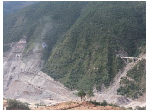
图 1 右岸天然边坡
