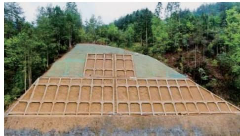
图 1 利咸高速边坡
