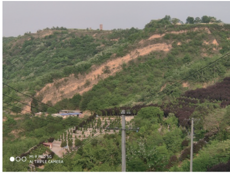
图 7 黄土-砂泥岩陡坡
