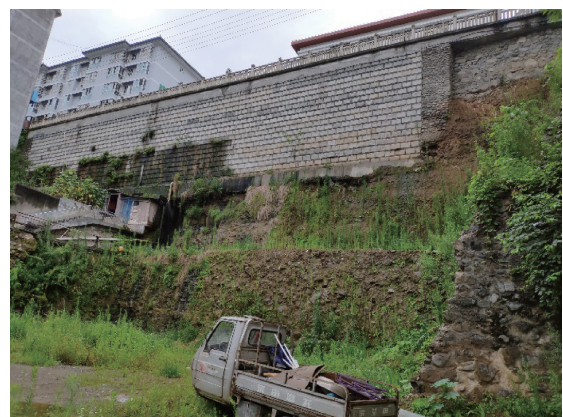
图2 填方边坡施工后情况
