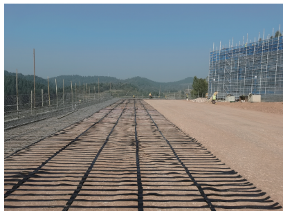
(b) 土工格栅铺设
