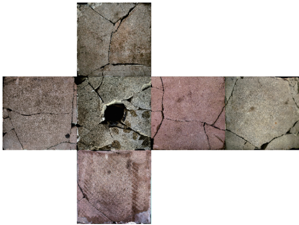
图 2 立方体水泥试样表面裂缝图像
